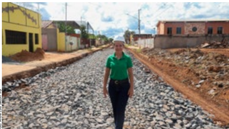
Prefeita Vistoria revitalização de asfalto na Ponte do Parque do Lago
